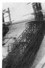
Fig. 5. — Armature d'une console.
